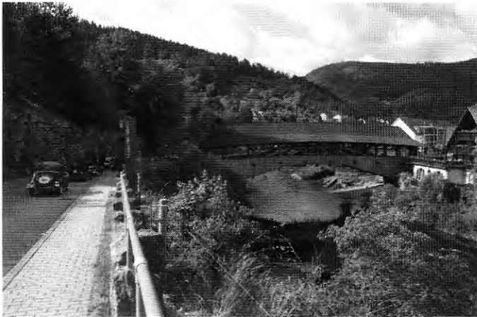
Auf dem Weg zur Forbacher Holzbrücke.
